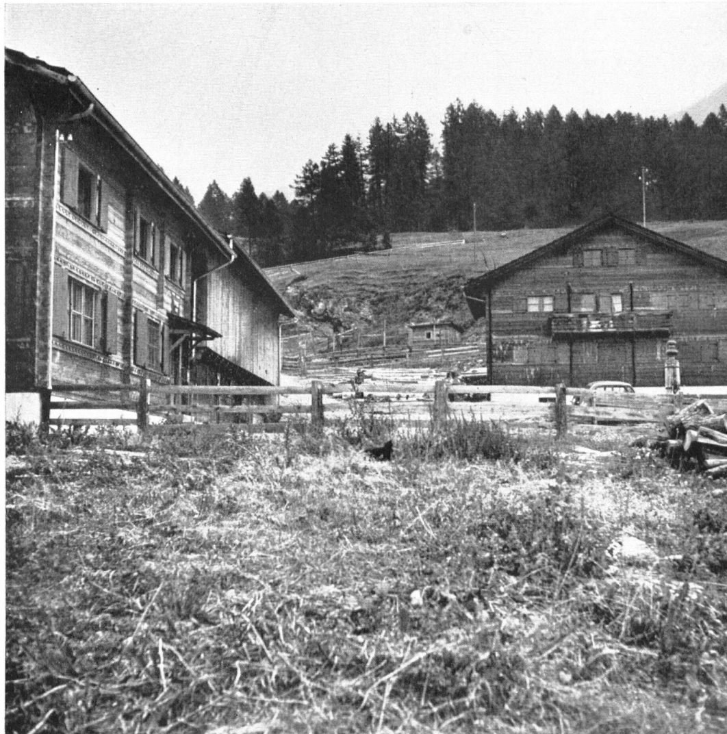
Der Dorfplatz von Neutrans, rechts das Schulhaus, in der Mitte einer der im Dorfzentrum gebliebenen neuen Bauernhöfe, links Bauernhaus mit Post. Auf dem Hügel ein Kinderheim. Auffallend ist, wie wenig gepflegt die Umgebung sich drei Jahre nach dem Brand immer noch darbietet. Siehe Text unten.
