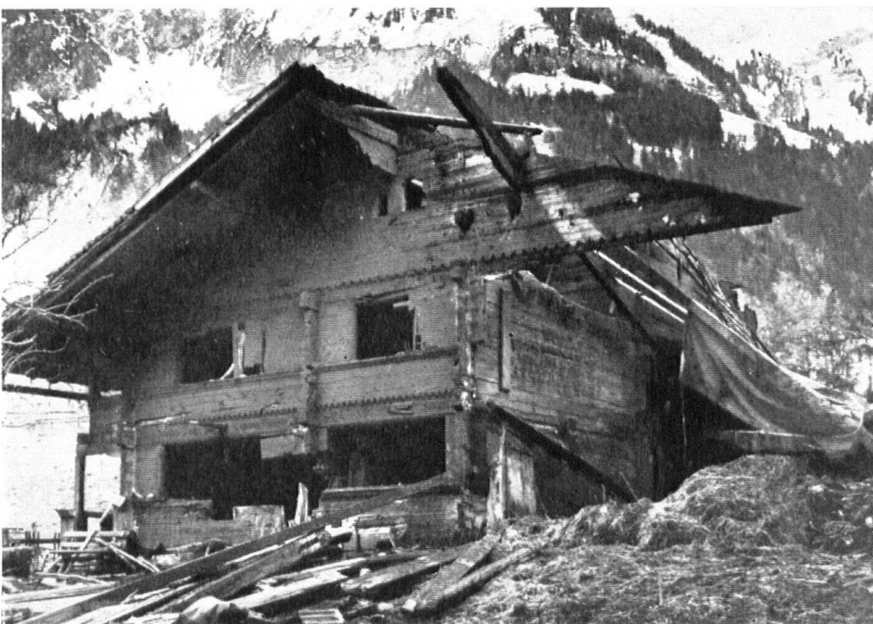
Bauernhaus in Mitholz, vom Feuersturm und Felshagel vernichtet. Ein mehr als 1 m 3 großer Betonklotz flog durch die Wand und zertrümmerte die Stube. Une maison soufflée par le déplacement d'air et hachée par les matériaux. Un bloc de béton d'un mètre cube vint crever la demeure.
