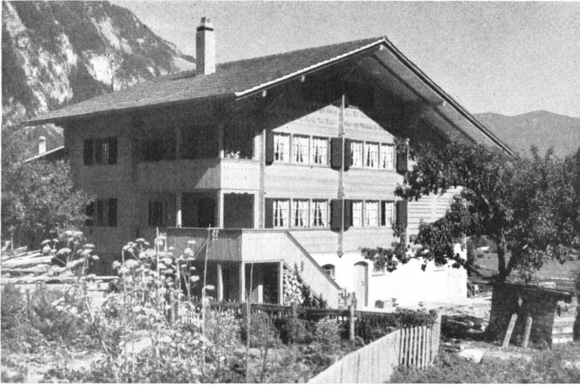
Zweifamilienhaus der Gebrüder Künzi. La maison à deux étages des frères Künzi.
