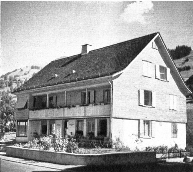
Neu-Stein. Bäckerei und Café Schönenberger; Arch. A. Heene, St. Gallen. Boulangerie et café Schönenberger. – Edifiées par plusieurs architectes choisis librement par les propriétaires, les constructions ont été soumises à l'inspection générale du Heimatschutz suisse ou, plus précisément, de M. Max Kopp, directeur du bureau technique.
