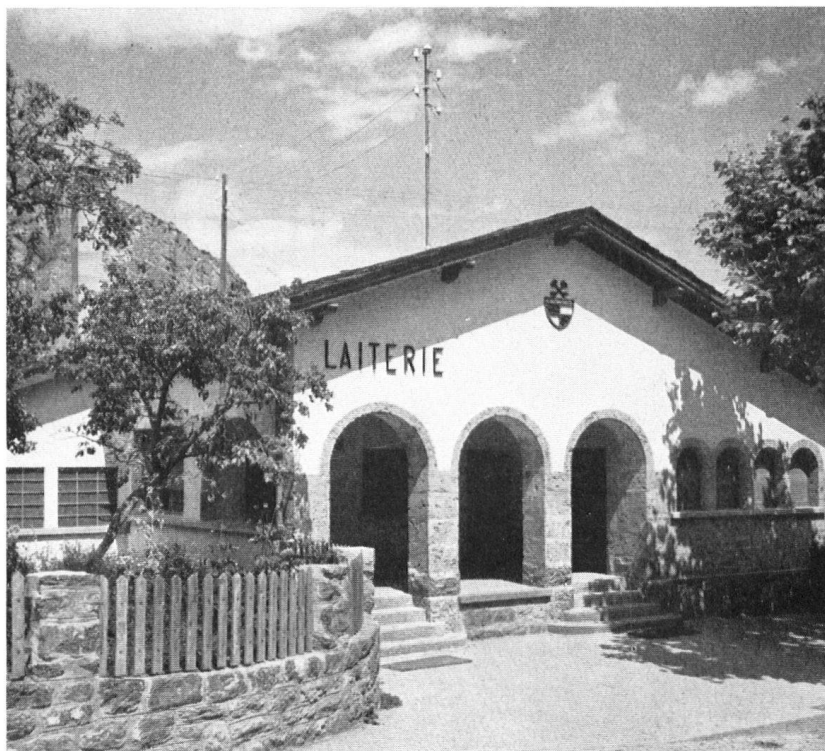
Chamoson voit surgir des bâtiments adaptés à leur destination où le style régional s'accorde à l'élégance. — La laiterie et son péristyle: le déchargement des « boilles » s'opère de plain-pied. Öffentliche Bauten im Walliser Ortsstil: die Molkerei von Chamoson. Beim Mittelbogen, ohne Treppe und Brüstung, stellen die Bauern ihre Brenten ab. (Auch hier vielleicht noch ein etwas Zuviel an Bogen. Das Motiv der Arkade würde wirkungsvoller zur Geltung kommen, wenn die Fenster daneben mit geraden Stürzen abgedeckt wären. Red.) Edifici pubblici nello stile locale: la latteria di Chamoson. Sotto l'arco di mezzo i contadini depongono le loro brente.
