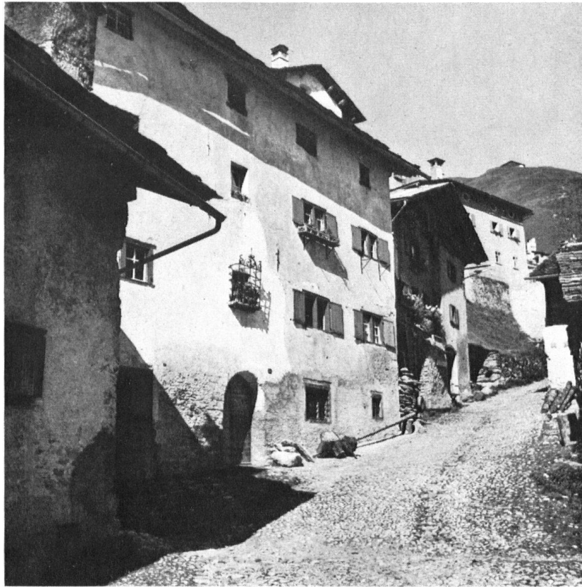
Splügen. Gasse mit Steinhäusern „an der Sust“.
