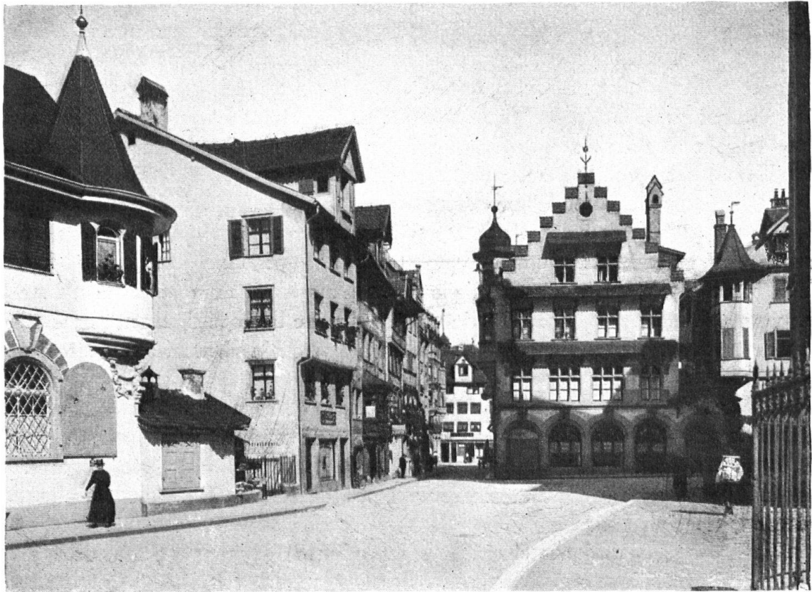
Vor dem Umbau. — Avant la reconstruction.
