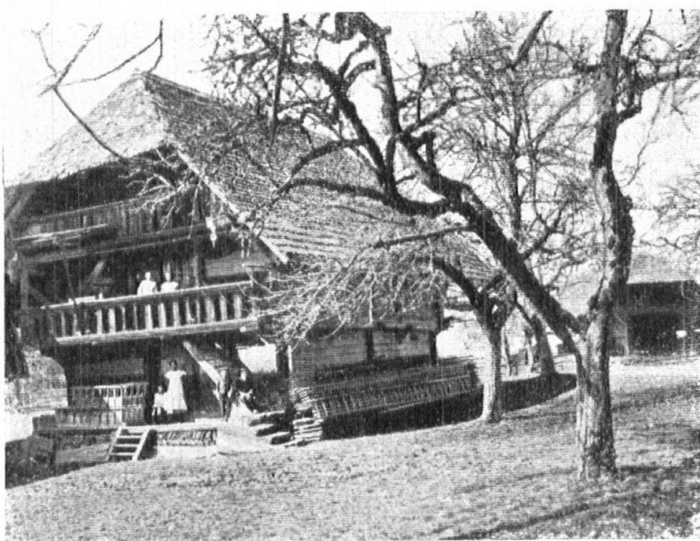
Speicher aus dem Jahre 1697. Mittleres Geschoss zweiräumig. Würfe fries an den Rahmenhölzern der Lauben. — Grenier, construit en 1697. L'étage moyen à deux pièces. La balustrade des galeries est décorée de frises cubiques.
