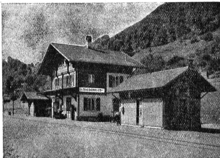
Station der Brienzseebahn. Eternit-Doppeldach, kupferbraun
