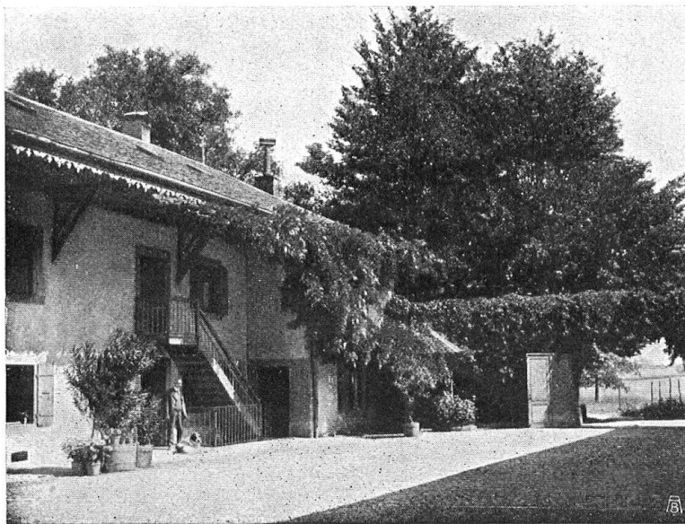
Abb. 12. Wohnung des Pächters in „Château des Bois“. Dank den Laubranken, die sich rings um das schlichte Gebäude ziehen, macht es einen freundlichen Eindruck. — Fig. 12. L'habitation du fermier à «Château des Bois». Grâce à la verdure qui l'encadre, la champêtre maison est accueillante.
