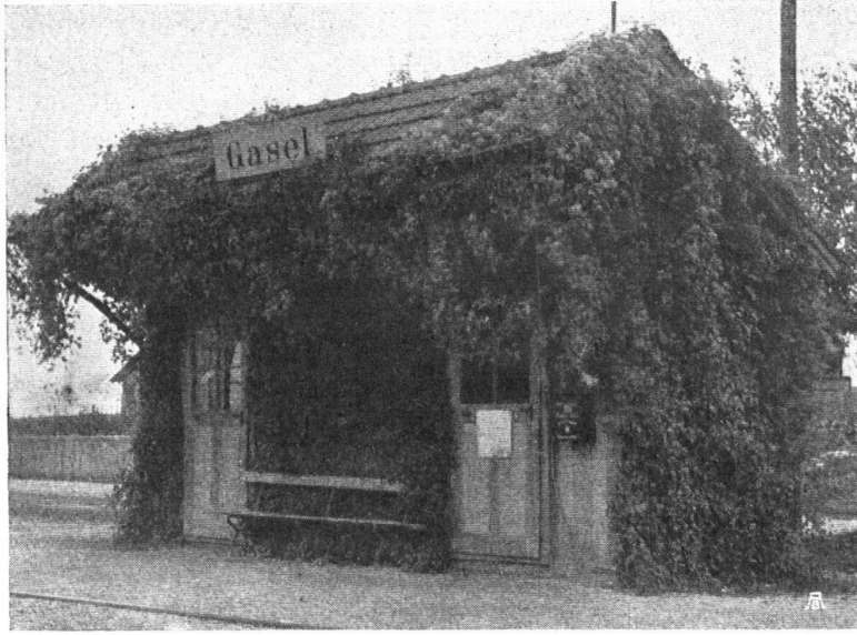
Abb. 3. Station Gasel (an der Linie Bern-Schwarzenburg). Primitivster Bau, von Waldreben umschlungen. Aufnahme von Max Schio, Hochbautechniker in Burgdorf. — Fig. 3. Halte de Gasel sur la ligne Berne-Schwarzenbourg. Petit bâtiment des plus primitifs tout embelli de climatis.
