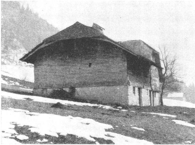
Fig. 5. Chalet vaudois, aux Pléiades sur Vevey; „tavillonné“ à la mode fribourgeoise. — Abb. 5. Waadtländer Sennhütte mit Schindelschirm. Aux Pléiades über Vivis.
