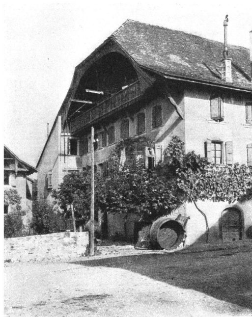
Fig. 9. Belle maison villageoise à Tercier, fâcheusement déparée par une annexe lourde et mal conçue. — Abb. 9. Schönes Dorfhaus in Tercier. Leider entstellt durch einen plumpen Anbau, unverständlich an und vor der Fassade angeflickt.
