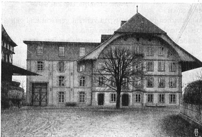
Abb. 17. Gegenbeispiel. Verunstaltung eines guten älteren Hauses durch das Anflücken eines formlosen Nutzbaues. Falsche Verbindung des alemannischen Daches mit dem flachen Holzzementdach. Mühle in Langenthal. — Fig. 17. Mauvais exemple. Belle maison bernoise complètement enlaidie par l'adjonction d'un bâtiment aux formes disgracieuses, dont le toit plat jure avec le beau pignon de l'ancienne construction: Moulin à Langenthal.
