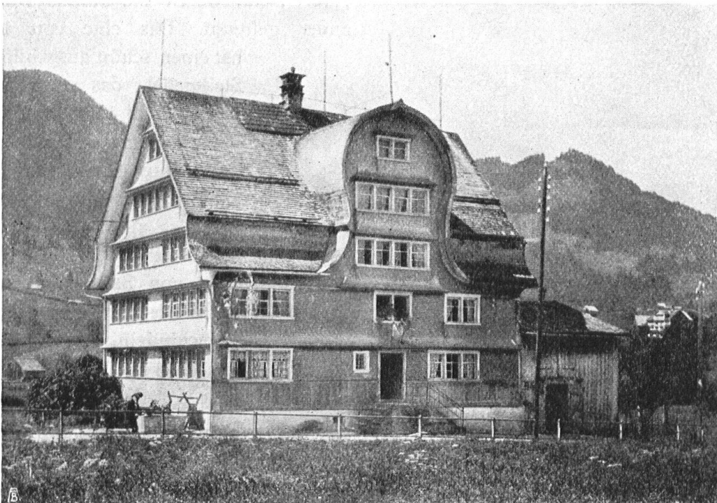
Abb. 12. „Rössli“ in Nesslau. Mansarddach mit geschweiftem „Guerhaus“. — Fig. 12. Hôtel du «Rössli» à Nesslau. Comble mansardé. Formes arrondies et originales de la mansarde.
