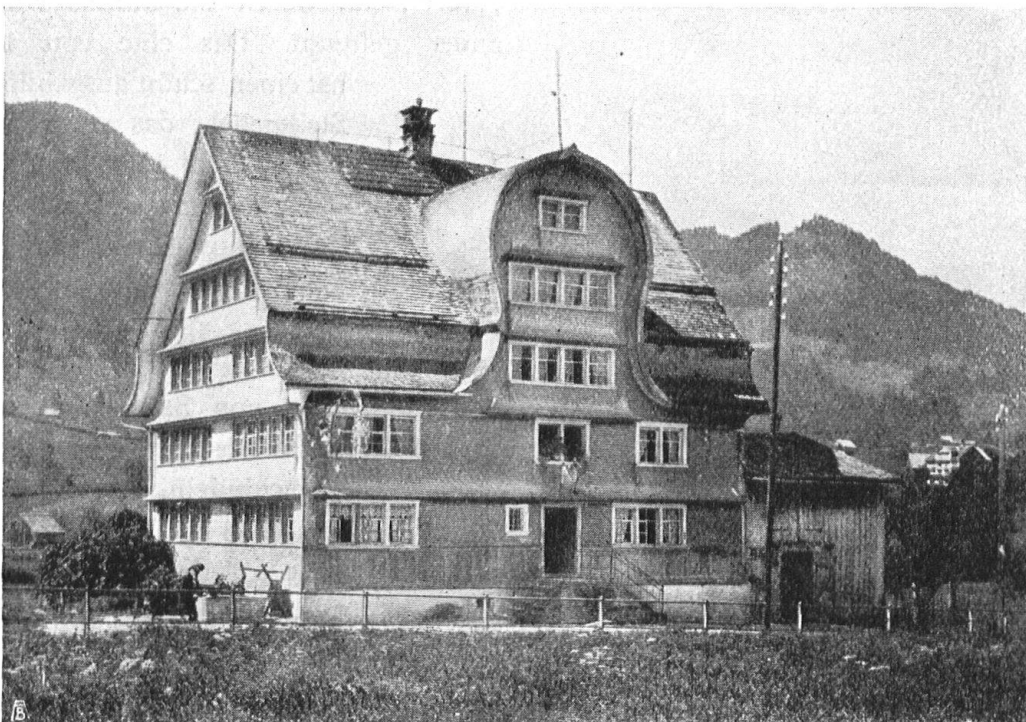
Abb. 12. „Rössli“ in Nesslau. Mansarddach mit geschweiftem „Guerhaus“. — Fig. 12. Hôtel du «Rössli» à Nesslau. Comble mansardé. Formes arrondies et originales de la mansarde.
