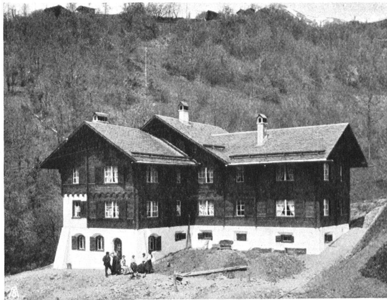
Abb. 11. Maschinistenwohnhaus des Elektrizitätswerkes der Stadt Chur. In waldreicher Gegend ein solid fundiertes Holzhaus. Architekt B. S. A. Willi , Chur. Aufnahme von A. Reinhard , Chur. — Fig. 11. Habitation destinée aux machinistes des usines électriques de la ville de Coire. Maison en bois élevée sur de solides fondements en pierre, en harmonie avec les belles forêts des environs
