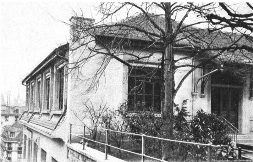
Abb. 19. Die neue Turnhalle auf Musegg, Luzern. (Architektur der städtischen Baudirektion.) Haupteingang, von beispielloser Nüchternheit. — Fig. 19. La nouvelle halle de gymnastique au Musegg à Lucerne. Architecture officielle de la ville. Entrée principale. Incroyable pauvreté d'invention.
