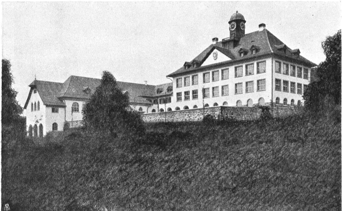
Abb. 15. Schulhaus in Meggen. Auf fallendem Terrain mit dem Nebenbau (Turnhalle und Feuerwehrdepot) zu einer einheitlichen Gruppe gestaltet. Das Dach über der einfachen, aber wohl proportionierten Fassade zeigt freie Verwendung älterer heimischer Baumotive. Architekten B. S. A. Gebrüder Pfister , Zürich. Fig. 15. Maison d'école à Meggen. Elevée sur un terrain en pente, elle forme avec ses annexes: la halle de gymnastique et le dépôt des pompes à incendie un ensemble harmonieux. Le toit sur une façade simple mais bien proportionnée suit librement certains motifs d'architecture locale.
