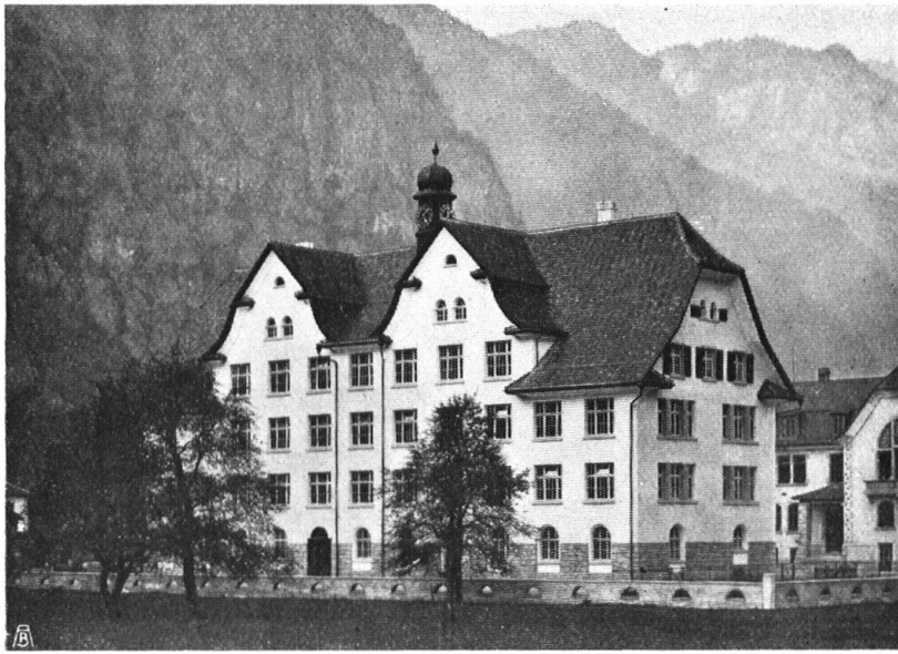
Abb. 7. Schulhaus in Erstfeld. Die eindrucksvolle Dachsilhouette vermittelt eine gelungene Gliederung des stattlichen Baues. Architekten Meili-Wapf & Amberg , Luzern. — Fig. 7. Maison d'école à Erstfeld. Bâtiment imposant aux proportions harmonieuses, grâce surtout à son toit qui donne à l'ensemble son aspect de parfaite homogénéité.
