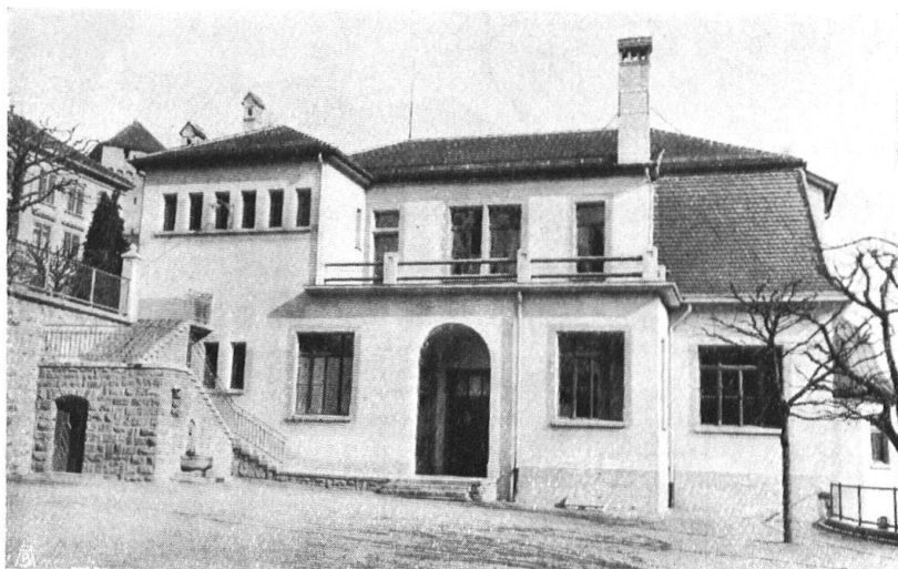
Abb. 21. Neue Turnhalle auf Musegg; Westfassade. Ein seltenes Sammelsurium von Fenster-, Tür- und Dachformen. Kaum mehr unter den Begriff „Baukunst“ fallend. — Fig. 21. La nouvelle halle de gymnastique au Musegg. Bizarre et chaotique assemblage de portes, de fenêtres et de toits. Il n'est guère possible d'appeler cela de l'architecture.
