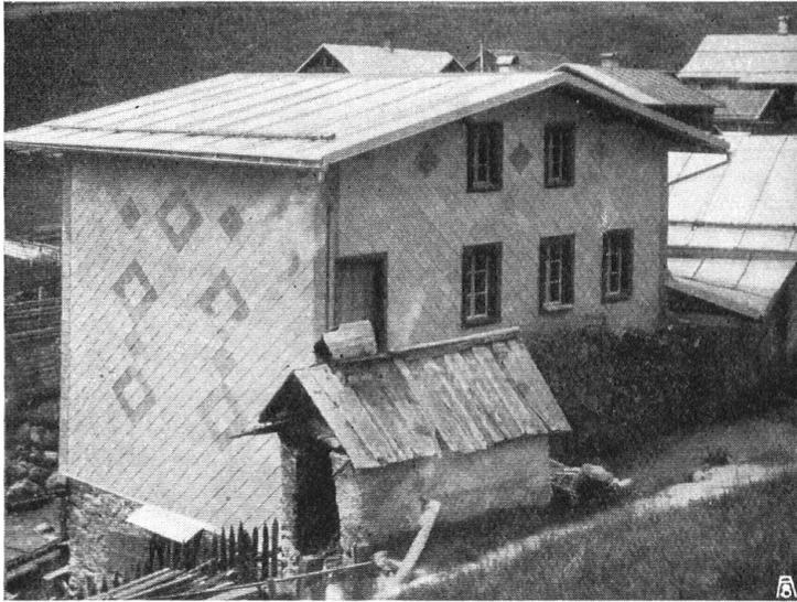
Abb. 13. Gegenbeispiel. Haus mit Eternitverkleidung und Blechdach. Bedachung und Hausverschalung wirken in ihrer hellen Färbung glatt, kahl und kalt. Ein Gegenbeispiel aus leider recht vielen, besonders im Bündnerland! — Fig. 13. Mauvais exemple. Maison aux murailles revêtues d'éternite. Le toit recouvert de tôle, de formes et de matériaux étrangers, frappe désagréablement par son aspect froid et nu et sa couleur trop éclatante. Exemple malheureusement trop commun dans les Grisons.
