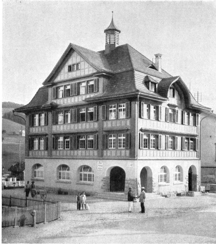
POST- UND SPARKASSENGBAEUDE IN DEGERSHEIM BEI FLAWIL. Beispiel eines guten, in heimischer Bauart ausgeführten öffentlichen Gebäudes. Erbaut 1908/1909 von den Architekten Curjel & Moser in St. Gallen.
