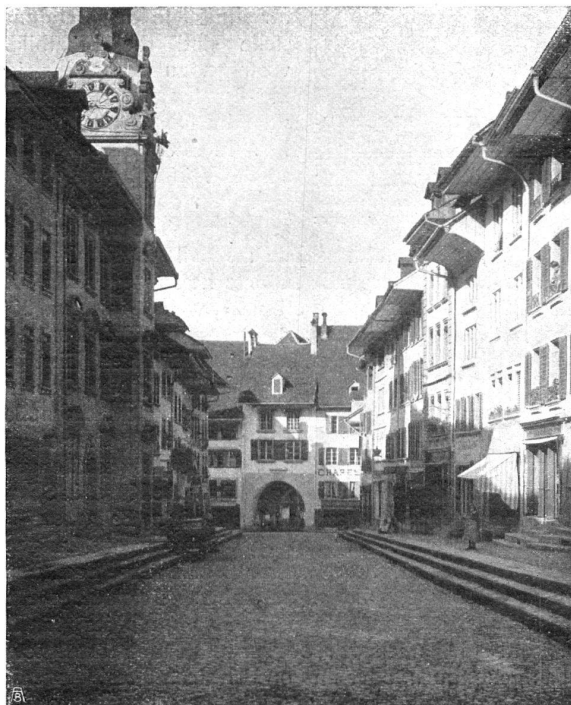
==== Blick nach dem Durchbruch der Rathausgasse zur Bahnhofstrasse L'arcade conduisant de la rue de l'Hôtel de ville à celle de la gare
