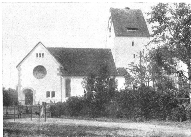
DIE ERWEITERUNG DER KIRCHE ZU FEHRALTORF (Kt. Zürich). Eine vorbildliche moderne Kirchenerweiterung, ausgeführt durch die Architekten B. S. A. Rittmeyer & Furrer, Winterthur.
