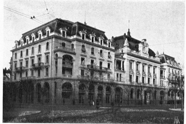
GEGENBEISPIEL: Ein neues öffentliches Gebäude, trotz grössten Schmuckaufwandes doch von geringer Wirkung und durch zwei „organisch“ (?) angebaute reizlose Miethäuser erdrückt MAUVAIS EXEMPLE: Un édifice public, flanqué de deux maisons de rapport. Le tout surchargé d'ornements
