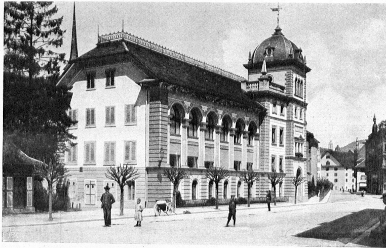
Schlechter moderner Umbau eines Staatsgebäudes, dessen kulissenmässig vorgeschobene Prunkfassade über Grundriss und Aufbau des alten Hauses hinwegtäuscht
