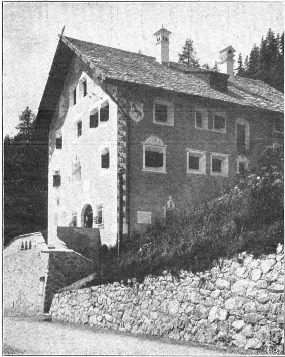
DAS ENGÄDINER MUSEUM in St. Moritz. Aus der Schweiz. Bauztg. LE MUSÉE ENGADINOIS à St-Moritz. Cliché de la Schw. Bauztg.
