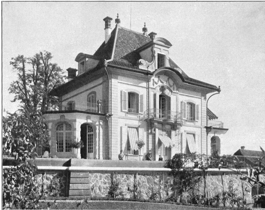
LANDHAUS BEI BERN. — Architekt H. B. von Fischer in Bern. — VILLA PRÈS BERNE.
