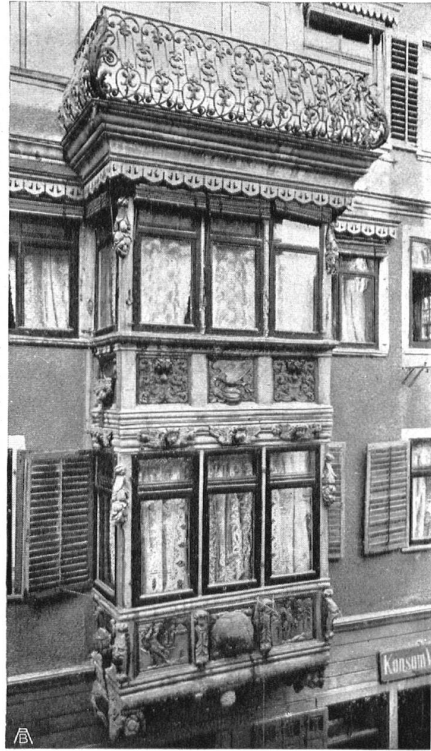
ERKER AM HAUSE „ZUR KUGEL“, durch den auf- gesetzten Balkon mit gusseisernem Geländer entstellt FENÊTRE EN SAILLIE à la maison de „la boule“, enlaidie par un balcon en fonte
