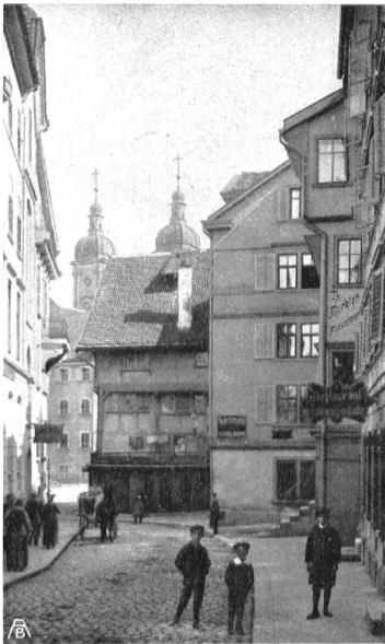
GALLUSSTRASSE früher „im Loch“. Die vor einigen Jahren gezogene Baulinie wird das den guten Abschluss des Gallusplatzes gegen diese Gasse bildende Haus „zur Linde“ wegrasieren und damit den geschlossenen Charakter des Platzes, eines der reizvollsten Bilder der alten Stadt, ohne zwingenden Grund vernichten. RUE DE GALLUS. La maison qui ferme la place est condamnée par le plan d'extension, au détriment de l'unité architectonique; un des coins les plus intimes de la ville sera détruit.
