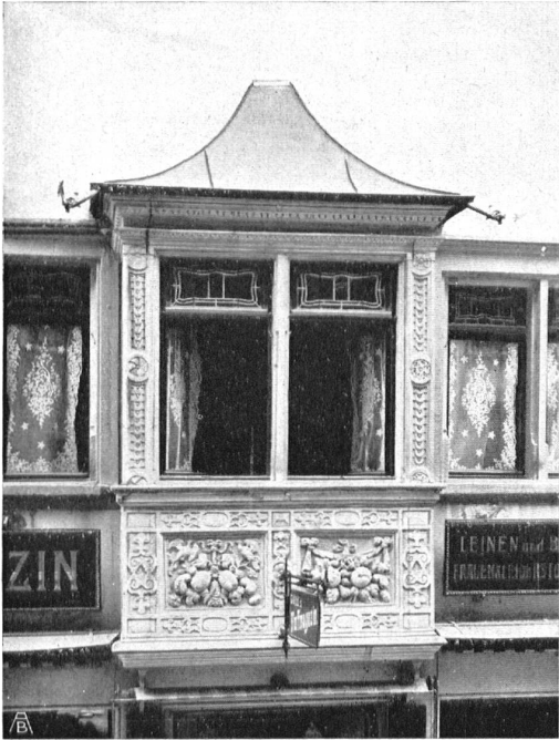
ERKER AM HAUSE NEBEN DEM GASTHAUS „ZUM SCHIFF“ in der Multergasse FENÊTRE EN SAILLIE près de l'hôtel „Schiff“, Multergasse
