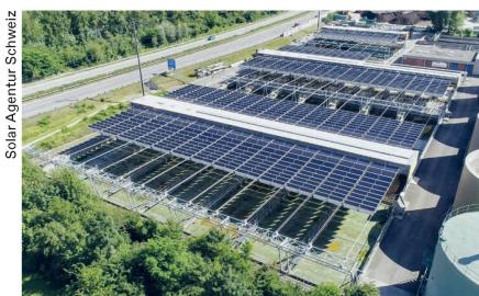
Kläranlage als Solarkraftwerk
