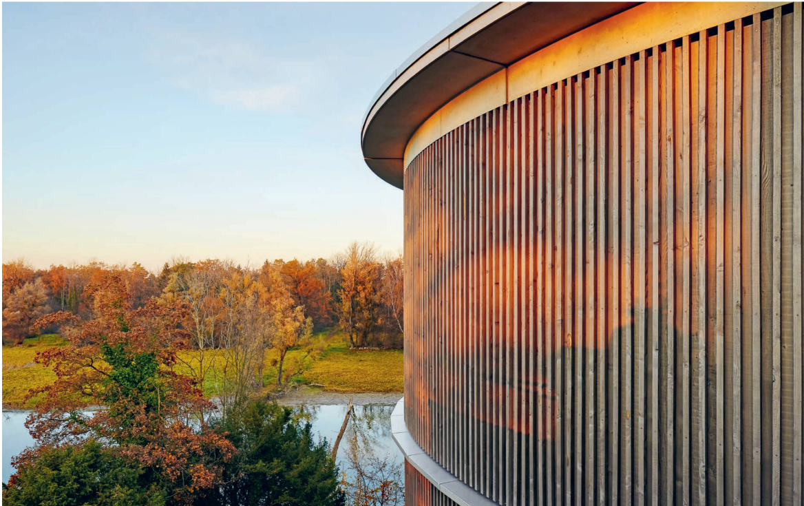
Die AVA – ausgezeichnet mit dem «Goldenen Schemel» 2023 des Heimatschutzes SG/AI La station d'épuration des eaux d'Altenrhein a reçu le «Goldener Schemel» 2023 de Patrimoine suisse, section SG/AI
