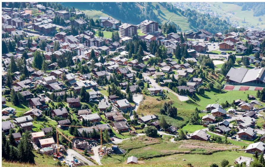
Fondation Franz Weber, Derrick Feole
