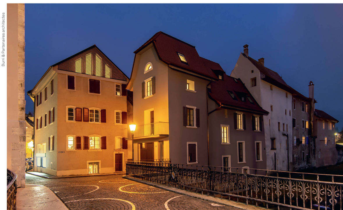
Les autorités communales de Porrentruy encouragent financièrement la réhabilitation de l'habitat dans le centre historique depuis 15 ans. Les deux bâtiments Cour aux Moines 10 et 11 après la réhabilitation (2013, 2017, 2018).
