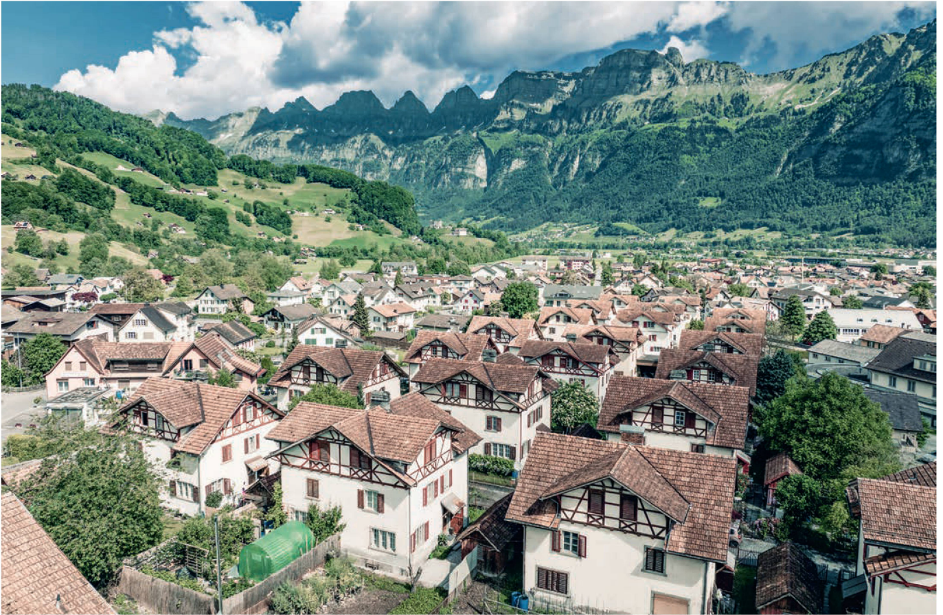
Im Neudorf Flums reihen sich 24 Doppelhäuser. Sie wurden in drei Etappen in den Jahren 1896, 1905 und 1909 erbaut. Le Neudorf, à Flums, comprend 24 maisons mitoyennes: elles ont été construites en trois étapes en 1896, 1905 et 1909.
