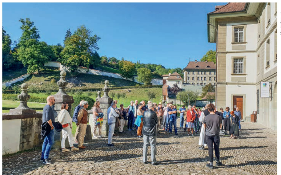
Le 22 septembre dernier, les membres de Pro Fribourg ont visité le chantier de restauration de l'église de l'abbaye cistercienne de Hauterive.
