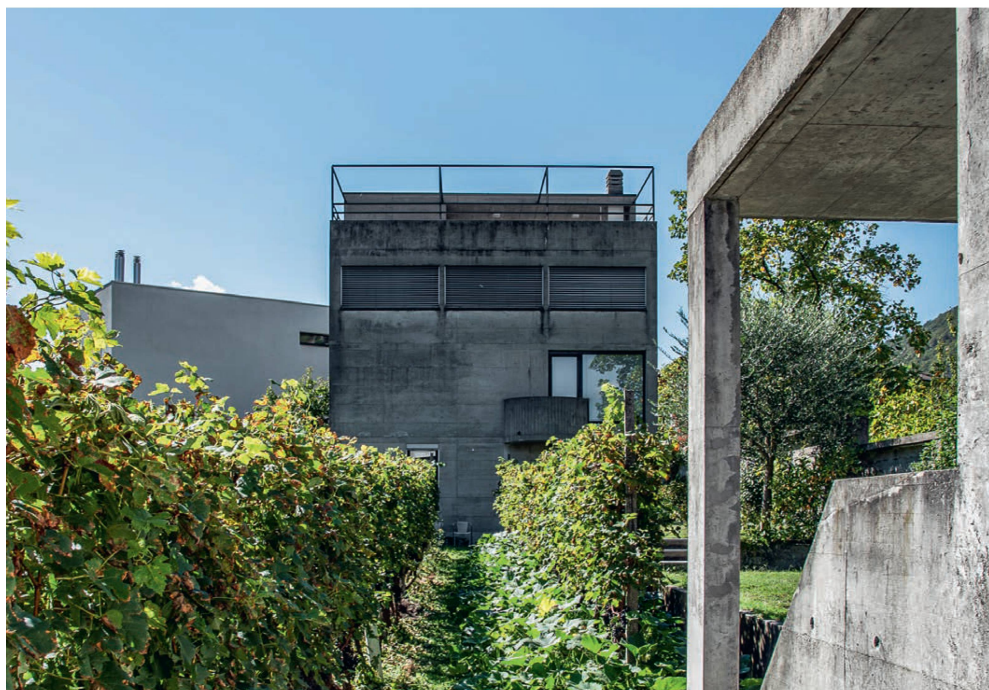
La maison du maire à Monte Carasso (TI), une réalisation de Luigi Snozzi (1977–1980)
