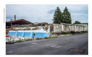
Im Sommer 2010 wurde in Goldach am Bodensee die frühere Filterhalle des Wasserwerks rücksichtlos abgebrochen. Es handelte sich um eine einmalige Konstruktion mit Pilzstützen, entworfen von Ingenieur Robert Maillart.
