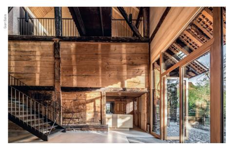
$Die freigespielte \, Hochstudkonstruktion \, im \, Dach$ Vue sur les poutres dégagées de la charpente
