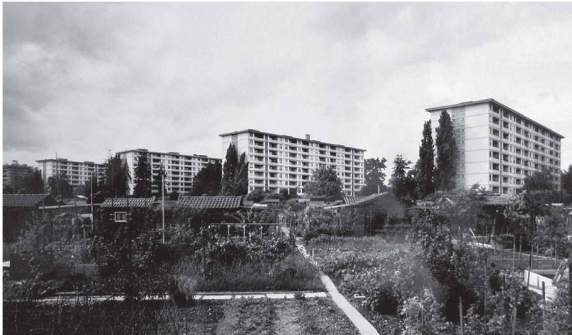
Überbauung Balexert in den 1960er-Jahren
