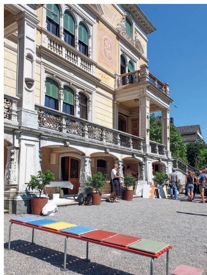
Mit Silikatfarbe bemalte Farbmuster sind vor der Villa Patumbah zum Trocknen ausgelegt.
