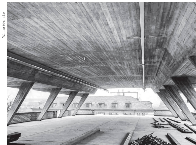
Die 1959 erbaute Werkhalle Hossdorf in Basel L'atelier Hossdorf construit en 1959 à Bâle
