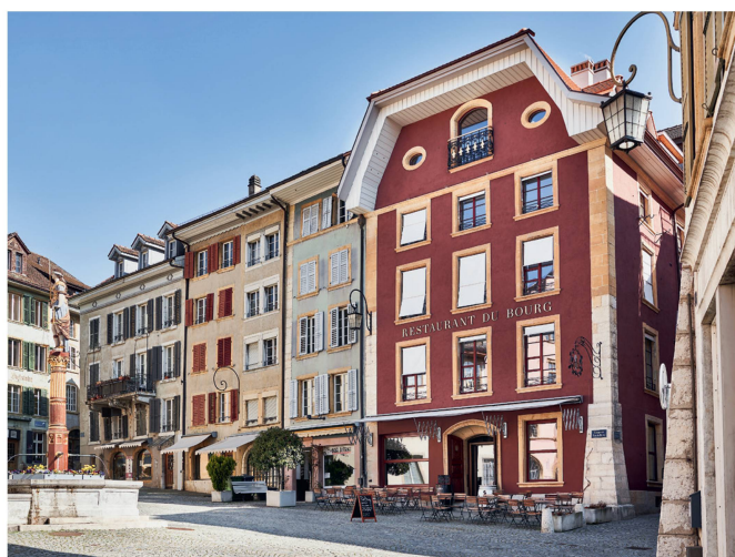
In der Dachstockwohnung über dem altehrwürdige Restaurant Du Bourg können neu Ferien mitten in der Bieler Altstadt verbracht werden.
