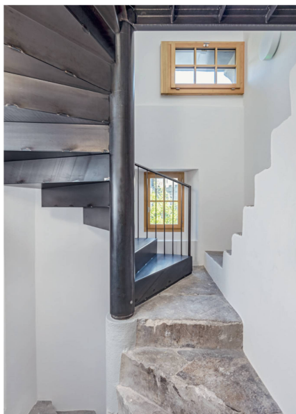
Die neue Stahltrappe im Obergeschoss steht im Kontrast zu den alten Granitstufen.
