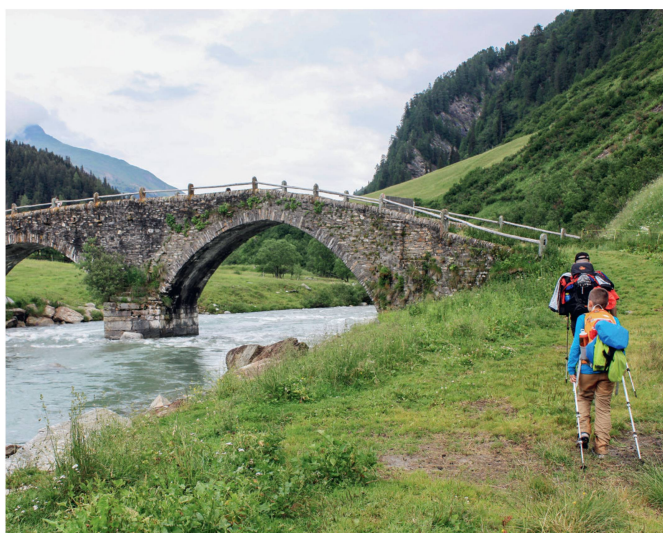
Alte Landbrücke bei Hinterrhein, erbaut 1692 von Peter Zurr, von den Einheimischen «Kapellbrüggä» genannt
