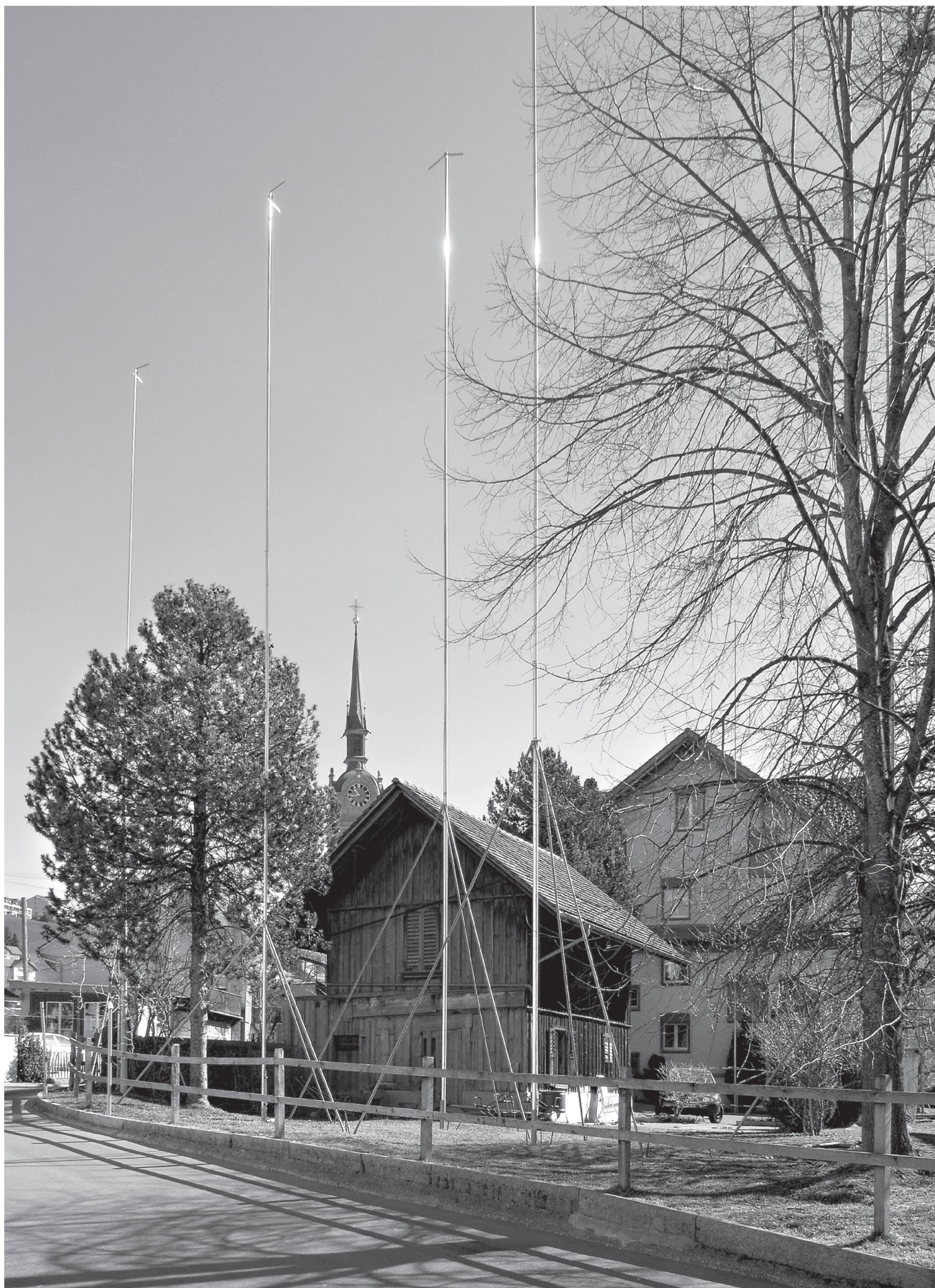
La Küfergasse à Oberägeri (ZG) An der Küfergasse in Oberägeri ZG
