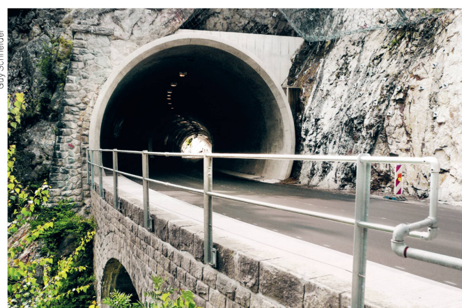
Sustenpass vorher (links) und nachher (rechts): Historische Mauern und zeitgemässe Betonkonstruktionen bilden am instandgesetzten Tunnelportal ein neues Ensemble.
