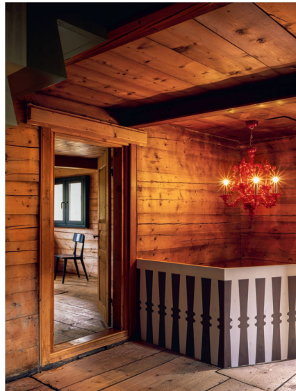
Sichtbarer Strickbau und aufgemaltes Treppengeländer im Obergeschoss
