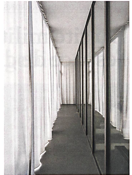
Wärme- und Kälteschutz: die 1,20 Meter breite Pufferzone lässt sich mit Vorhängen schliessen.
