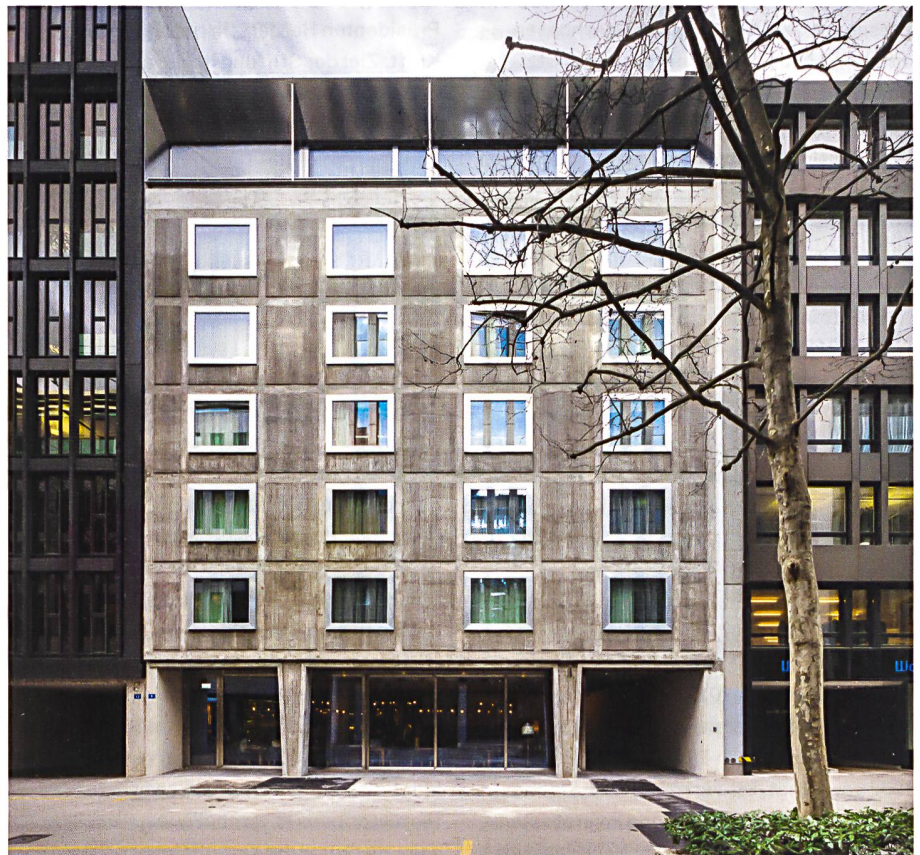
Um- und Neubau Brunngässlein 8, Hotel Nomad – einer der drei prämierten Bauten des Basler Heimatschutzes
