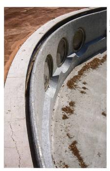
Le concept de restauration prévoit la réfection du pourtour du bassin, des hublots, de la mosaïque de verre du fond et des parois du bassin et le maintien du système d'origine d'écoulement des eaux.
