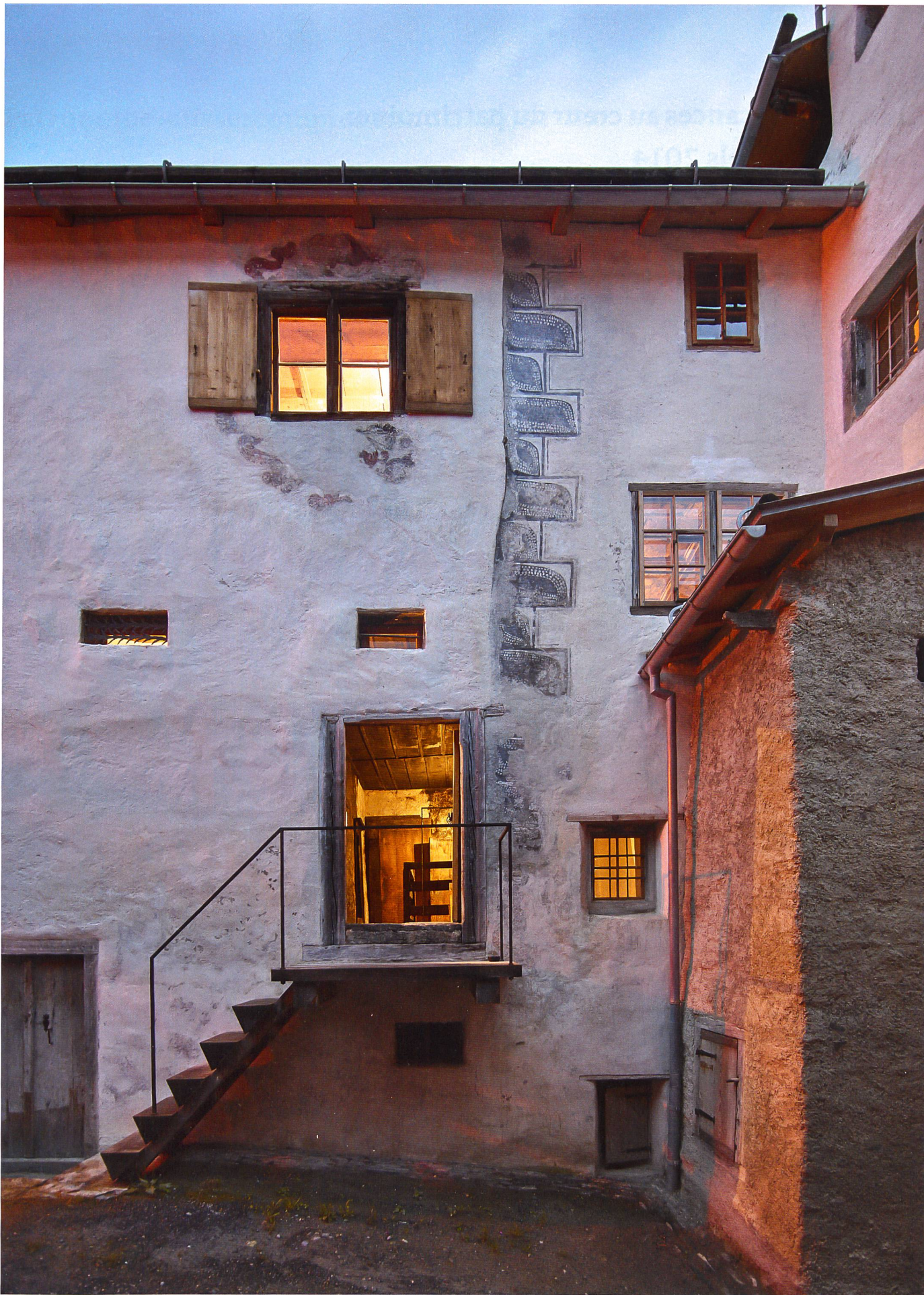
Depuis la fin octobre 2014, Vacances au cœur du patrimoine propose la location de la Turalihus de Valendas (GR), remise en état dans les règles de l'art par les architectes Capaul & Blumenthal.
