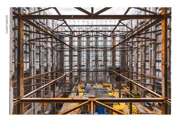
Photo de chantier: l'intérieur totalement évidé et les façades étayées (2013) Die Baustelle mit ausgehöhltem Gebäude und gestützten Fassaden (2013)
