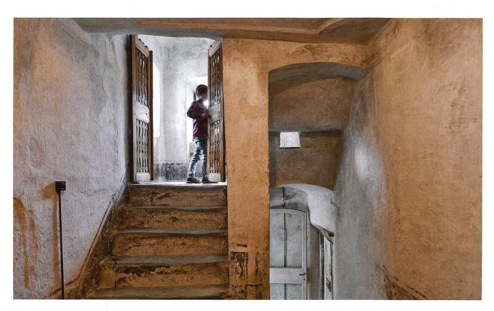
Remettre en état au lieu de remplacer: le crépi de la cage d'escalier de la Türalihus a été restauré dans les règles de l'art. Instandstellen statt ersetzen: Der Verputz im Treppenhaus des Türalihus in Valendas wurde aufwendig restauriert.
