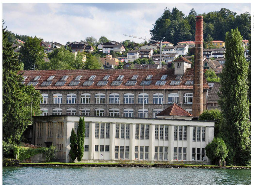
Das Industrieensemble auf der Halbinsel Giessen bei Wädenswil
