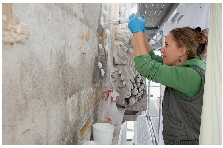
Mit fachgerechten Injektionen werden an der Aussenfassade Hohlstellen im Verputz aufgefüllt. Traitement des trous dans le revêtement de la façade par des injections de produits spécialement étudiés
