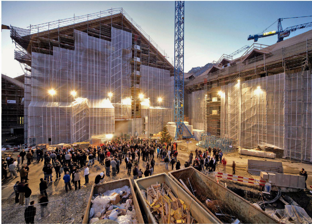
Aufrichtefeier für den Hotelneubau The Chedi in Andermatt am 9. September 2011
