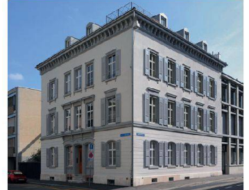
Drei prämierte Basler Bauten: das «Volta-Zentrum», der Spiesshof und das Haus Leonhardsstrasse 37. (Bilder ZVG)
