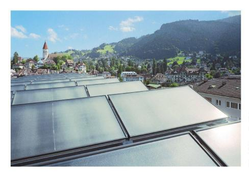
Die Produktion von Wärme ist in der Regel an den Ort des Verbrauches gebunden: Niederlassung der BEKB in Thun mit 100 m² Sonnenkollektoren für Warmwasser, Heizung und Kühlung (Bild Solar Agentur Schweiz)
