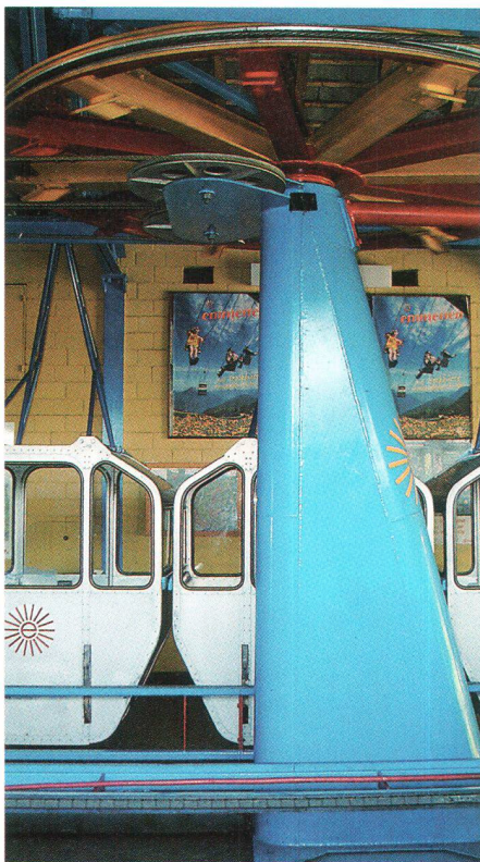
La télécabine Emmetten–Stockhütte de 1968 est la dernière installation du système Müller encore en l'état original (photo Patrimoine suisse)
