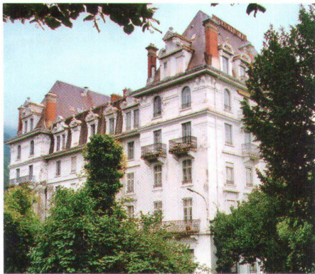
Höchst gefährdet: das Hotel National (Bild SHS) Menace très forte pour l'hôtel national (photo Ps)
