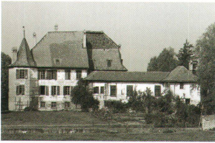
Südostfassade von Schloss Mézières im Zustand von 1989 (Bild P. Bosshard) Façade sud-est du château de Mézières en 1989 (photo P. Bosshard)
